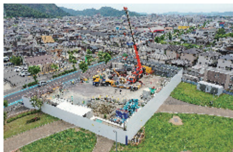
住宅密集地でも安全な掘削ができる シールドマシンを地中へ入れる様子
