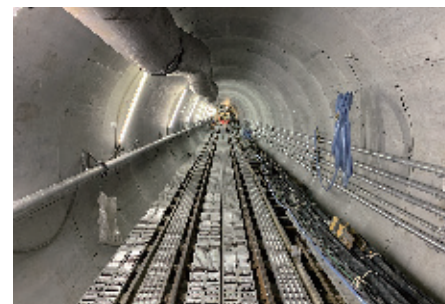
雨水排水路の内部
